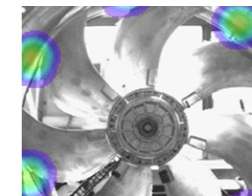
설비 유지 보수 (주요 소음원)
